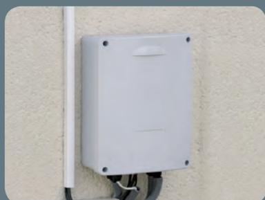
Armoire de commandes comprenant une platine électronique de gestion 12 volts, Réception radio incorporée 433 Mégahertz, Batterie 12 V/ 7A/h de secours
